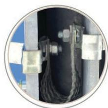
• Tresse métallique vis-écrou M6
